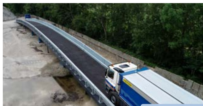
De slimme, tijdelijke brug 'HUGO' van KWS is een lichtgewicht demontabele brug.
