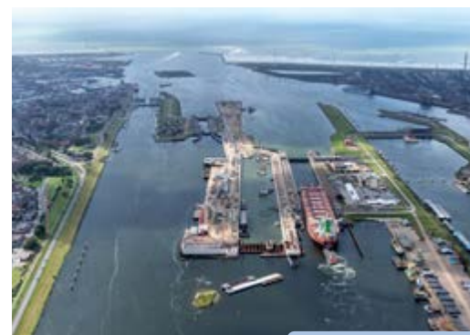
Bouw van de grootste Zeesluis ter wereld in IJmuiden.
