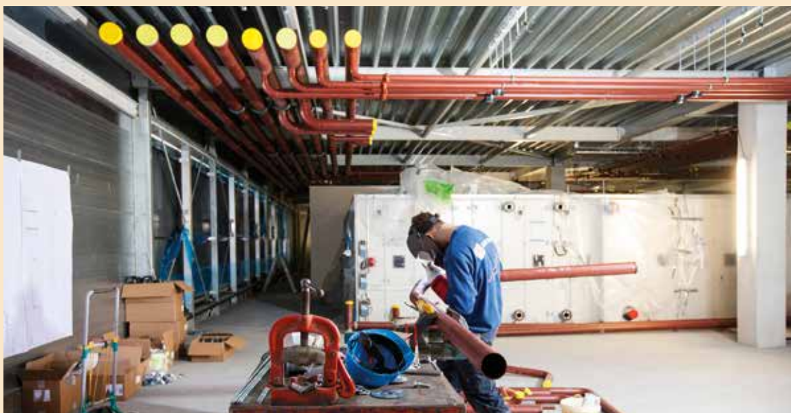
In de technieklaag van het OK-complex wordt het koude- en warmtedistributiesysteem aangelegd
