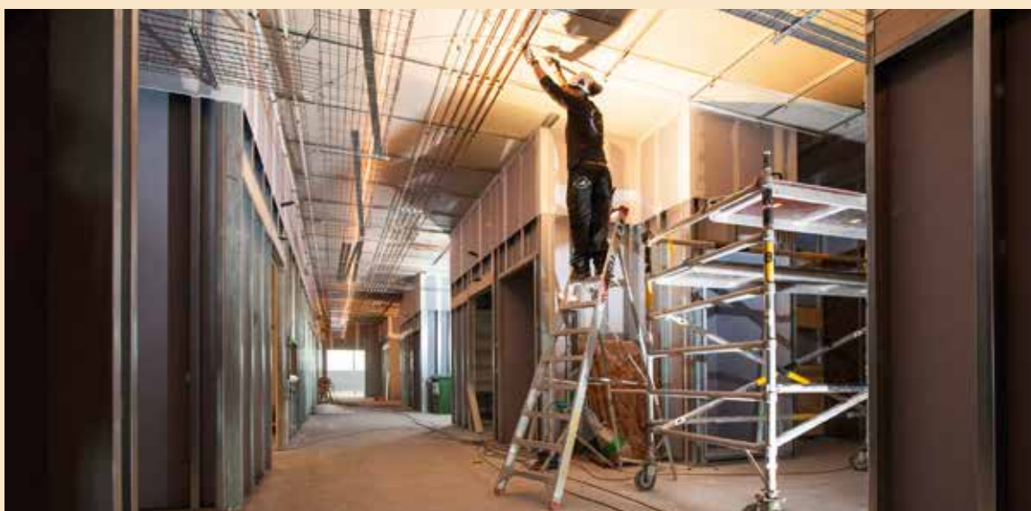
De leidingen voor medische gassen op het OK-complex worden aangelegd
