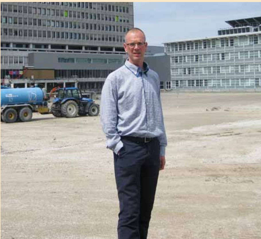
“De korte bouwtijd is de grootste uitdaging in de nieuwbouw van het HagaZiekenhuis” (Foto: Natalie Blomsma)
