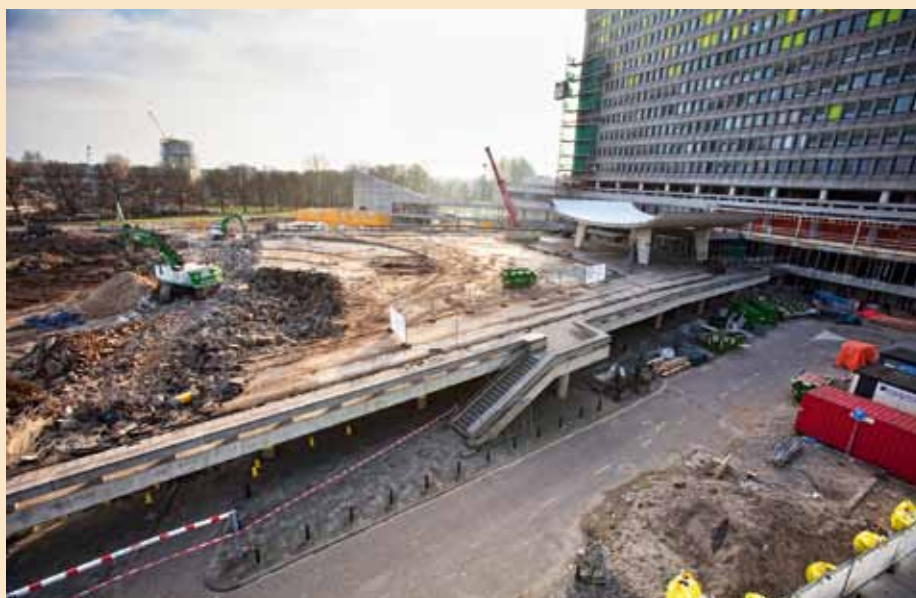
In februari is begonnen met de sloop van de voorkant van het ziekenhuis ter voorbereiding op de nieuwbouw
