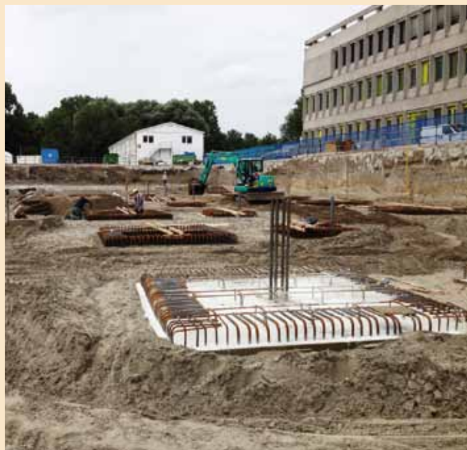
In augustus worden de eerste funderingsblokken geplaatst
