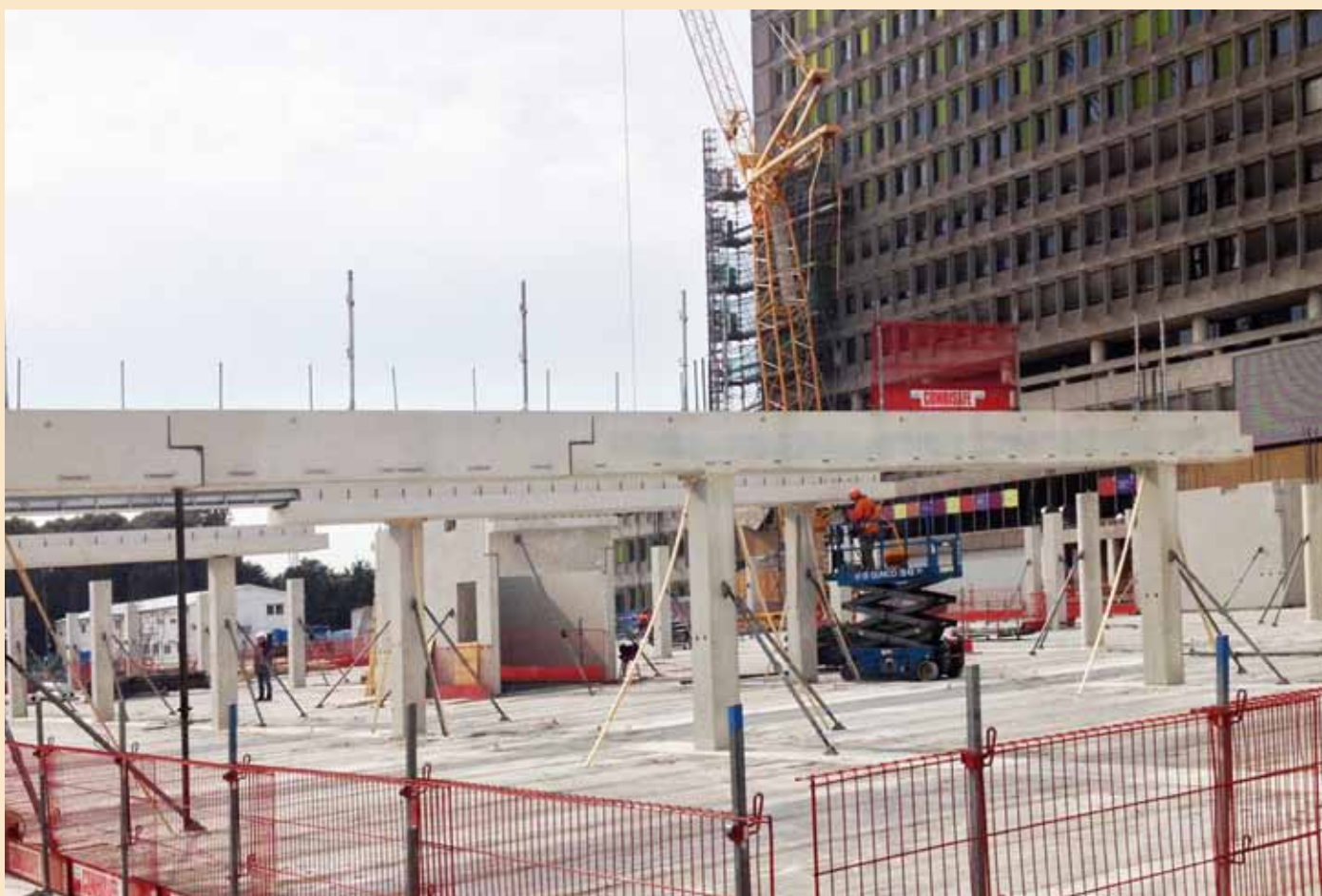
Oktober: de nieuwbouw krijgt snel gestalte met kant-en-klare bouwdelen
