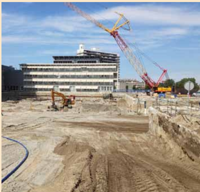
In juli starten de graafwerkzaamheden voor de bouwkuip
