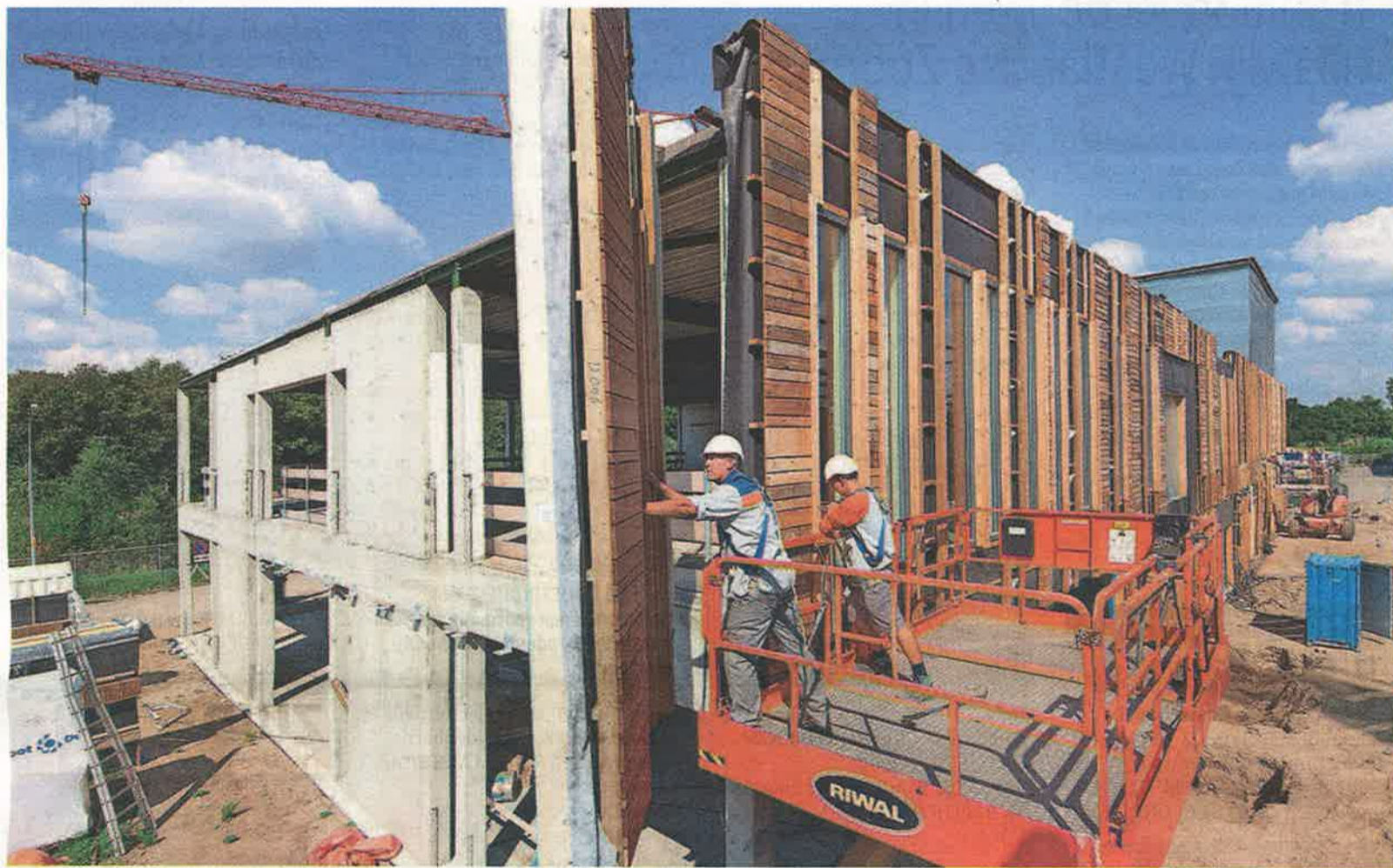
Minstens 80 procent van het materiaal dat wordt gebruikt voor het kantoor van Alliander is gerecycled. Foto: Volker Wessels
